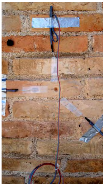
Foto 3: Col·locació de les galgues i preparació de la superfície per la perforació
