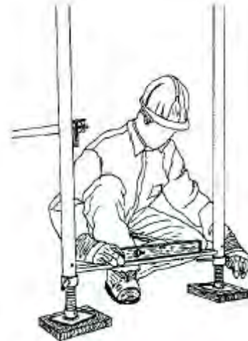
Comprobación de la nivelación horizontal
