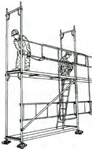
Montaje del resto del andamio
