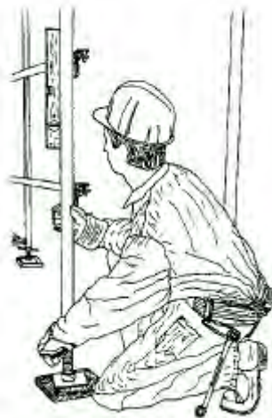
Comprobación de la nivelación vertical
