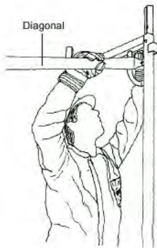
Colocación de la diagonal con abrazadera en el ensamble
